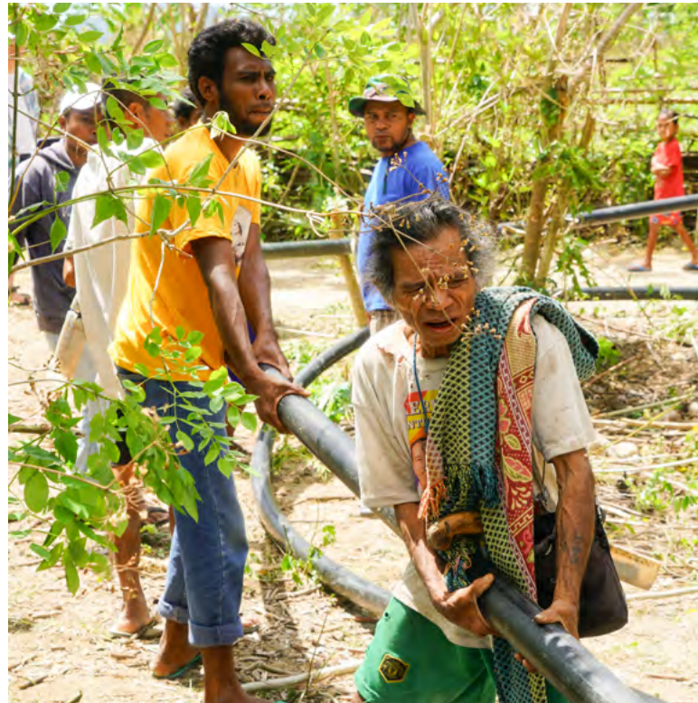
Di tengah panas yang terik di Nusa Tenggara Timur, masyarakat Desa Boen bersatu untuk membangun pompa air bertenaga surya. Mereka memasang pipa sejauh 3 kilometer untuk memperoleh akses air bersih.
